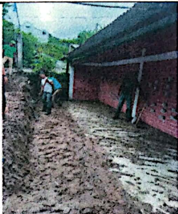
Foto 1: Inicio del mejoramiento tipo pórtico
